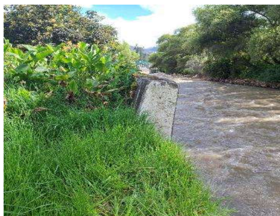
IMAGEN 03: SE OBSERVA EL RIO CHONTA (RIO CAJAMARQUINO), EL MURO DE CONCRETO SOCAVADO POR EL CAUDAL DEL RIO ASI MISMO PRESENTA INCLINACION POR LO QUE SE TIENE QUE DEMOLER Y CONSTRUIR UN MURO
